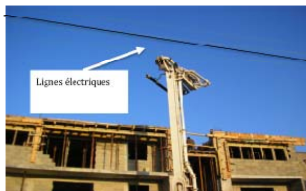
Photo 3 - Le déploiement de la flèche
