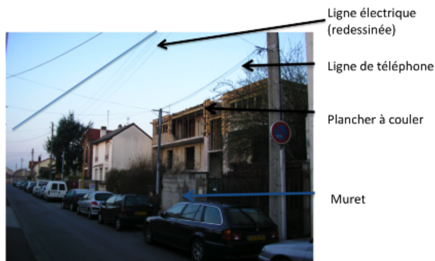
Photo 1 - Le chantier de livraison
