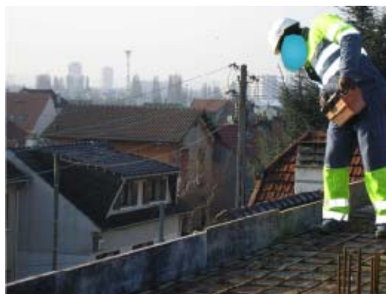
Photo 4 - La réalisation des contrôles
